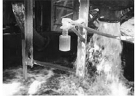
LR725D 应用于污水池 测量多点液位，并测量其液位差
